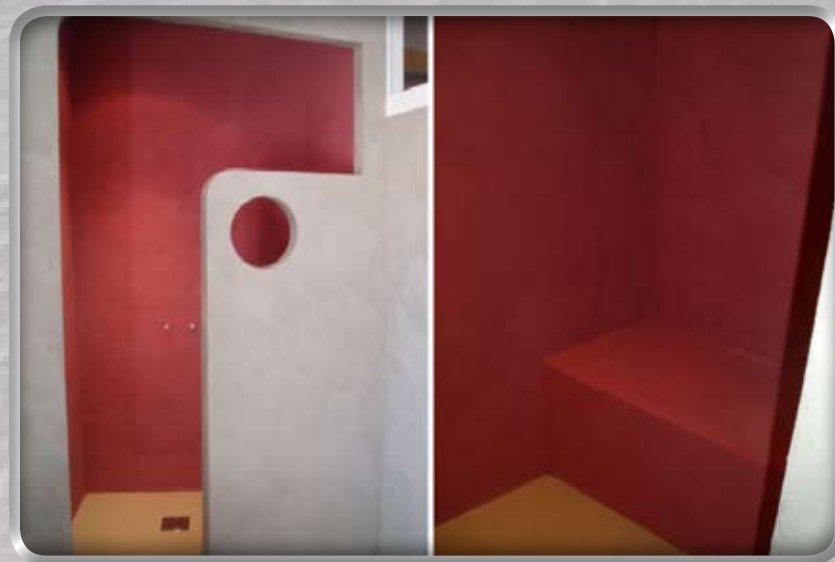
Douche italienne béton
